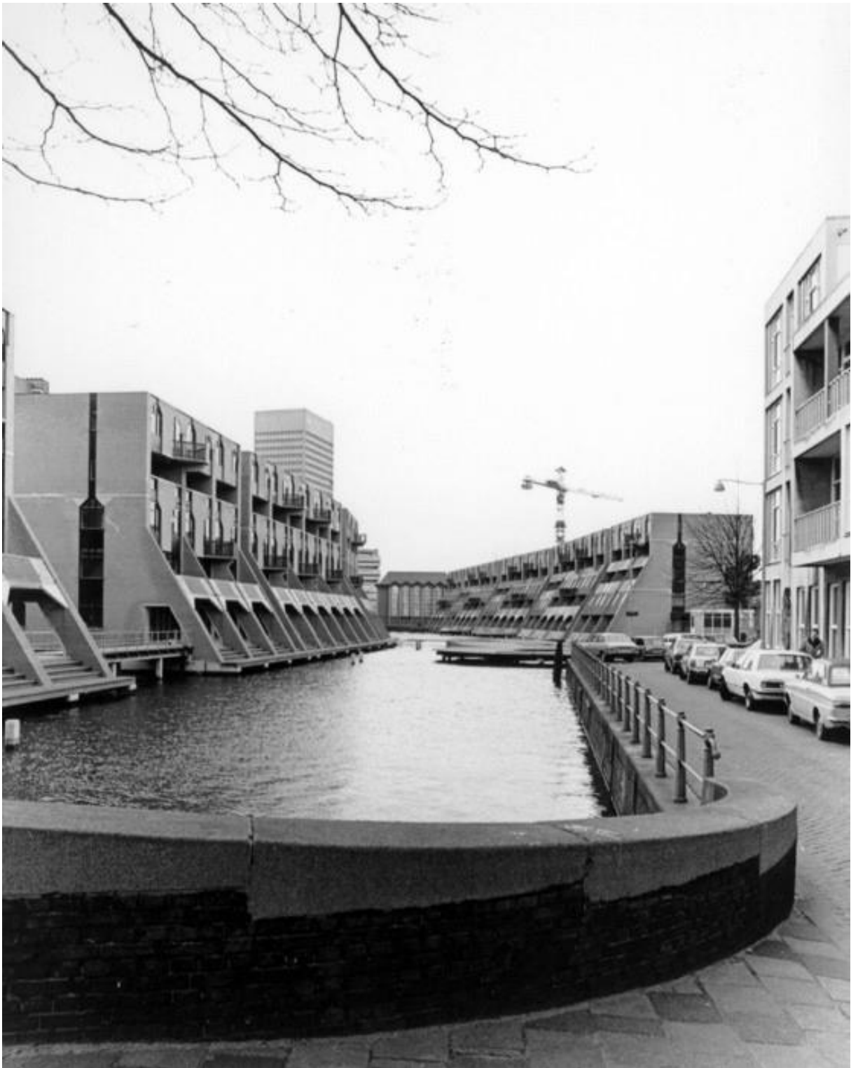
Foto 7. De eerste: nieuwbouw voltooid, 27031979 (1). Het "eilandje" is al aangelegd, maar bebouwing is nog niet aanwezig. Het houten loopbruggetje over de Delftsevaart is zo te zien al wel aanwezig, maar nog zonder de hoge bovenbouw van houten balken.
