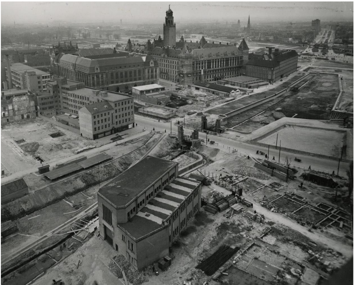
De situatie in 1943. De Delftsevaart is sterk verbreed; de nieuwe kademuren zijn opgemetseld en zijn hier prima te zien, omdat er nog geen water in de Delftsevaart staat. In het midden van de foto loopt van links naar rechts de Meent. Halverwege de Meent zien we de Meentbrug met de vier bakstenen heftorentjes. Let ook op de linker hoektoren van het stadhuis. De schade van het bombardement wordt hersteld, want de toren staat in de steigers. Een informatieve foto en ook wel zeer indrukwekkend, deze foto van het stadscentrum, zo in het midden van de oorlog.
