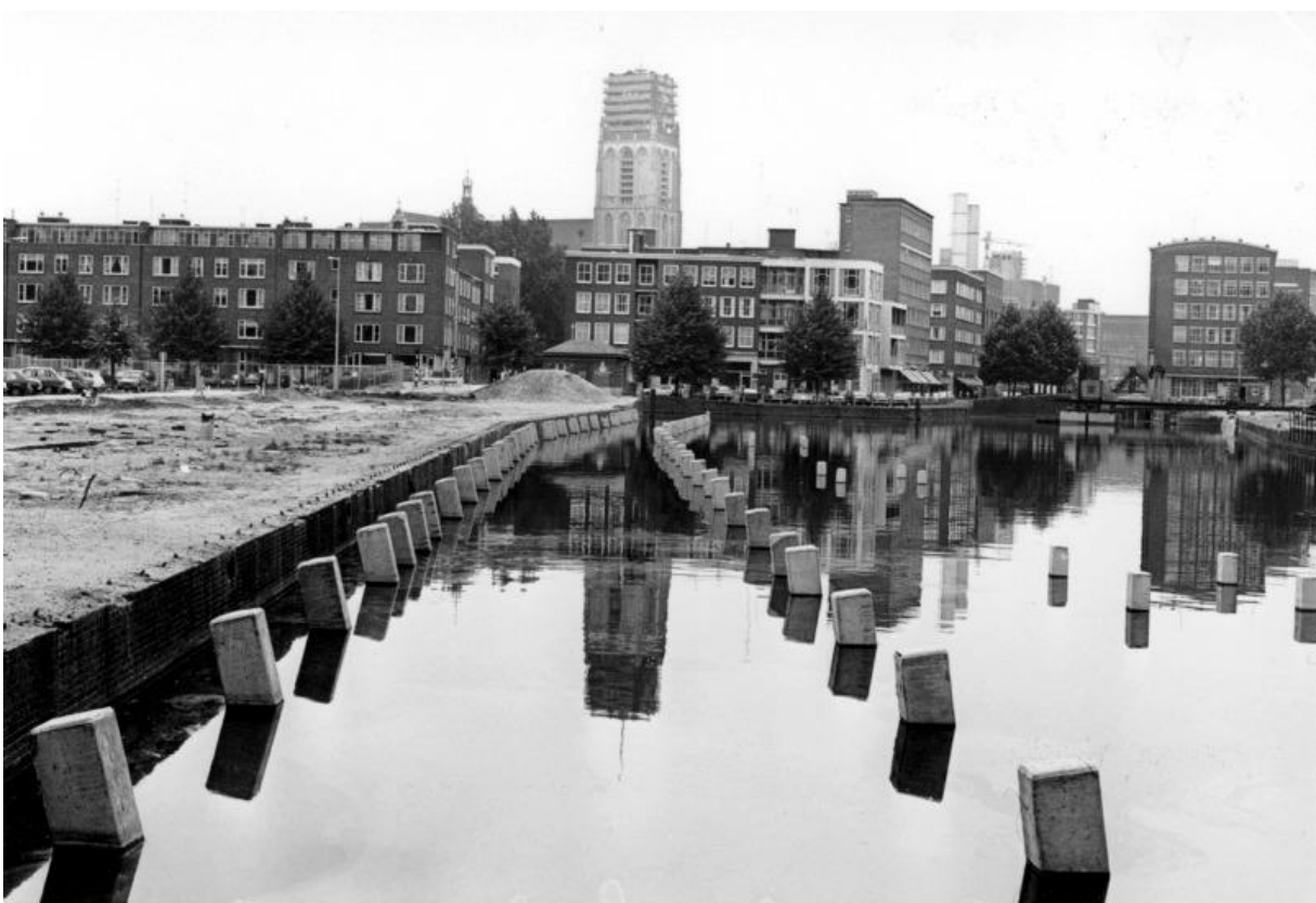
Foto 4. Funderingspalen in het water van de Delftsevaart, 28071977. De palen zijn enigszins schuin geheid, dit vanwege de schuin oplopende achtergevel. De groepjes van de vier kleinere paaltjes zijn voor de funderingen van de houten vlonders.
