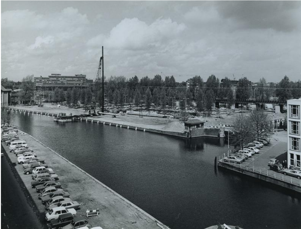
Foto 3. Heien betonnen funderingspalen, 12051977 (2). Een heipaal is tot aan de heistellage gereden. Op de achtergrond een stapel andere heipalen. Het "eilandje" is nog niet aangelegd.
